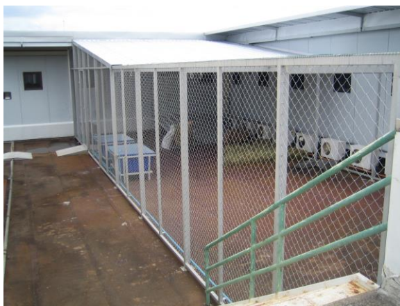
ต่อเติมหลังคาบริเวณที่ล้างอุปกรณ์
